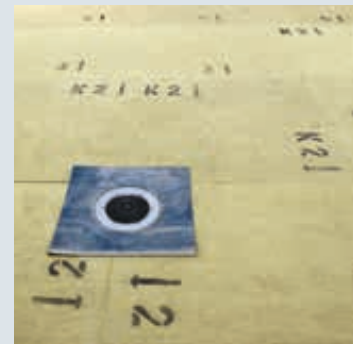
Das Wasser wird kontrolliert abgeführt.
