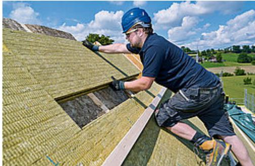
Druckfeste, grossformatige Dämmplatte, allseitig mit Nut und Kamm. Vollflächige Dämmschicht für Steildach- und Wandaufbauten.
