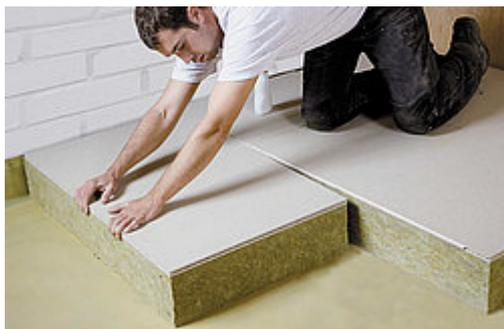
Homogene Dämmplatte im Verbund mit einer genuteten 16 mm Holzspanplatte als begehbare Dämmelement für den Dachboden-Estrich. Hartholzfedern für die Montage werden mitgeliefert.
