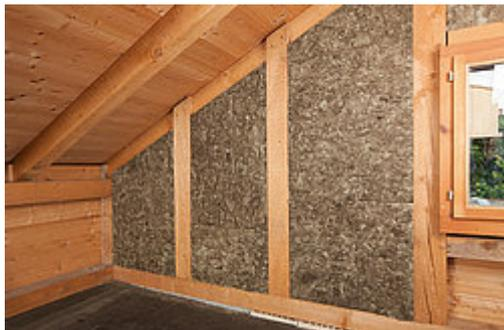
Universaldämmplatte auch für Ausfachungen im Holzbau und für Kerndämmungen in Zweischalenmauerwerken geeignet.
