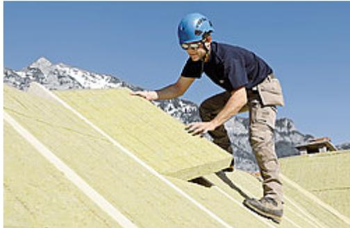
Zweischichtige Dämmplatte mit elastischer Unter- und härterer Aussenschicht. Steildachdämmung über den Sparren, zwischen Lattungen sowie für das Flumser- oder Eigerdach. Estrichbodendämmung (Dachboden) unter Verlegeplatten.
