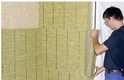
Homogene Dämmplatte mit spezieller Oberfläche und guter Putzhaftung für Leibungen bis 50 mm.
