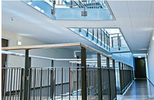
Homogene Dämmplatte mit Sichtoberfläche aus grau weiss gesprenkeltem Glasvlies. Kanten umlaufend gefast und weiss gestrichen. Für Keller-, Hallen- und Tiefgaragendecken sowie für Innenräume mit akustischen Anforderungen.
