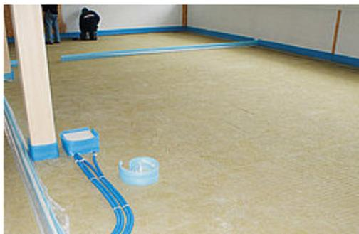
Homogene, widerstandsfähige Dämmplatte für erhöhte mechanische Belastungen unter schwimmenden Unterlagsböden. Als Kerndämmung bei zweischaligen Betonwänden.
