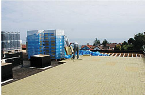
Zweischichtige Dämmplatte für den Einsatz in Flachdächern, welche nur beschränkt für den Unterhalt begehbar sind. Auch als Gefälledachlösung erhältlich.
