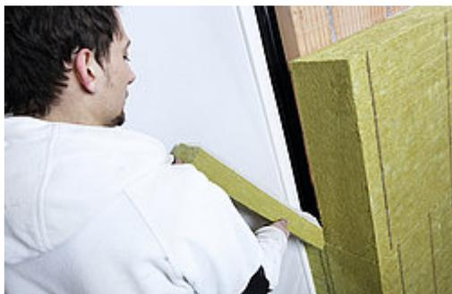
Homogene Dämmplatte mit spezieller Oberfläche und guter Putzhaftung. Für Stürze, Leibungen bis 50 mm sowie Elemente für Aussenwärmedämmsysteme.
