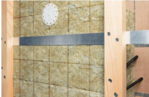
Zweischichtige Dämmplatte mit elastischer Innen- und härterer Aussenschicht mit Einschnitten im Abstand von 200 mm. Vollflächige Dämmung in hinterlüfteten Fassaden für Montagesysteme mit Distanzschrauben und Aluwinkelprofilen.
