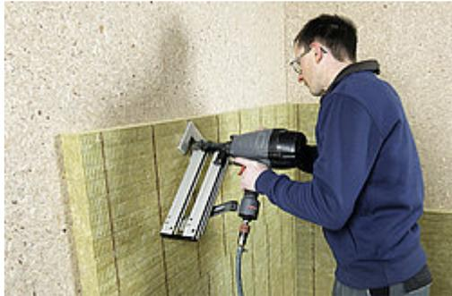
Zweischichtige Dämmplatte mit spezieller Oberfläche. Beste Putzhaftung für verputzte Aussenwärmedämmssysteme im Holzbau. Geklammert auf Untergründe aus Plattenwerkstoffen.
