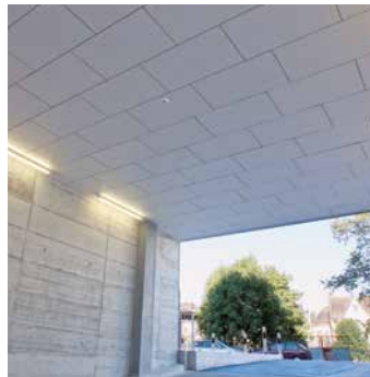
Esempio di accesso a un'autorimessa sotterranea.
