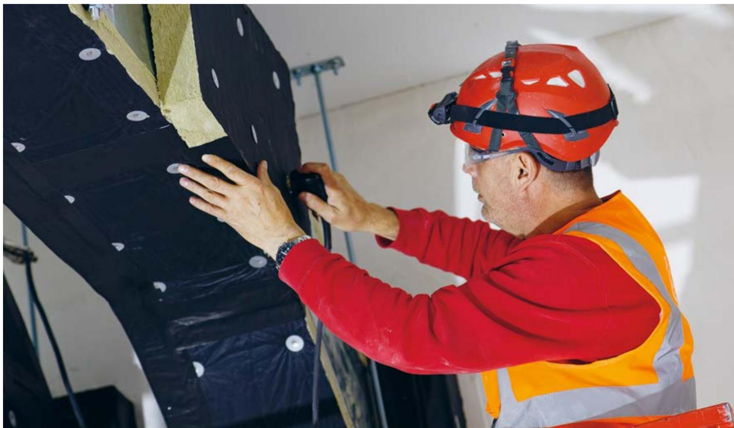
*Le point de fusion de la laine de pierre Flumroc à plus de 1000 °C en fait un matériau idéal pour l'isolation technique.*
