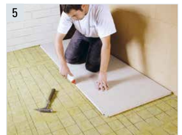
5 Nun wird die begehbare Holzspanplatte (19mm) verlegt. Nut und Feder mit Holz-Kaltleim verkleben.
