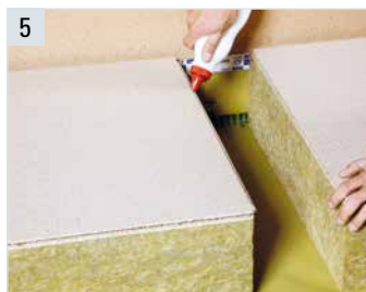
5 Nut und Feder der begehbaren Holzspanplatte werden mit Holz-Kaltleim verklebt.
