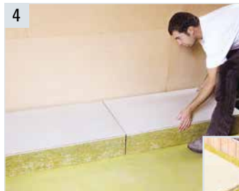
4 Verlegen des Estrichbodenelements ESTRA.
