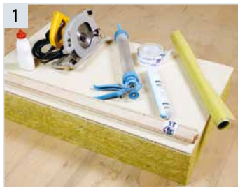
1 Arbeitsutensilien: wasserfester Holz-Kaltleim, Silikon, geeignetes Klebeband, Luftdichtigkeitsschicht, Handkreissäge, Hartholzfedern
