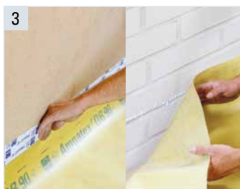
3 Stösse und Randfugen mit geeignetem Klebeband bzw. geeignetem Randanschlusskleber luftdicht verschliessen.
