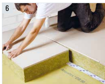
6 Die gesamte Fläche kann nun verlegt werden. Kreuzfugen sind zu vermeiden.
