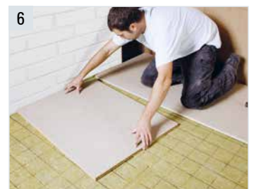
6 Die Holzspanplatte flächig verlegen. Stösse fugenversetzt, Kreuzfugen vermeiden.
