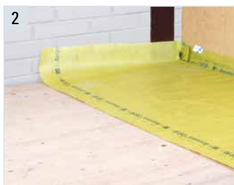
2 Luftdichtigkeitsschicht flächig verlegen.
