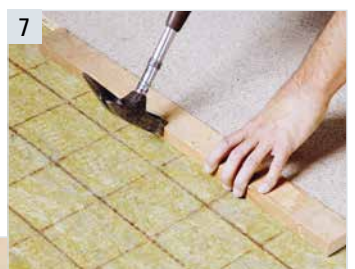
7 Die Fugen durch Klopfen bündig verschliessen. Als Kantenschutz ein Schlagholz verwenden.
